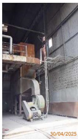
รูปที่ 2-29 อุปกรณ์ดูดฝุ่น (Local Exhaust)
